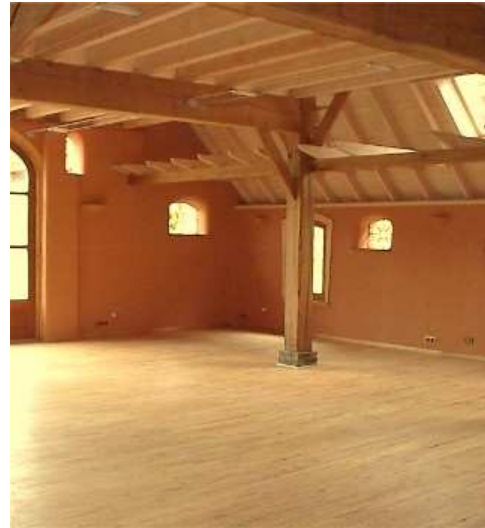
Aanbrengen binnenisolatie. Vergunning nodig
