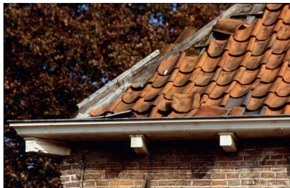
Herstel lood en pannen conform bestaande toestand: vergunningvrij
