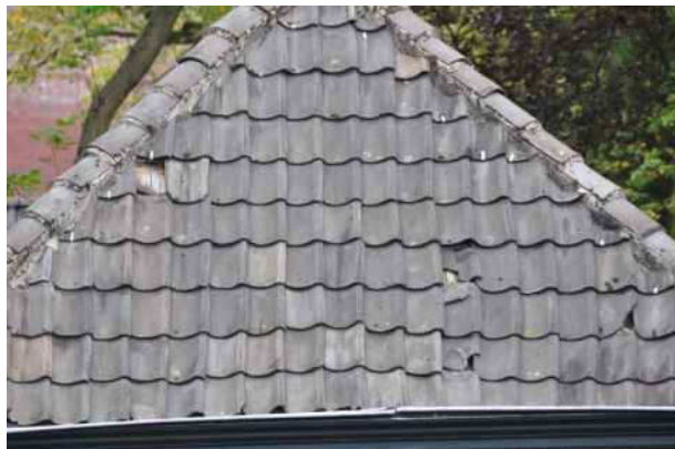
Vergunning voor vervangen dakpannen?
